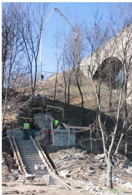
A viadukthoz vezető lépcső munkálatai
